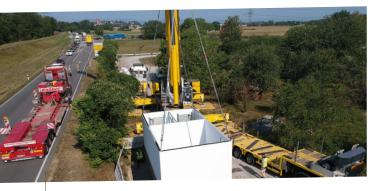
**Projekt:** Station für Industrie- und Ortsnetz Auftrag: Anlieferung und Montage einer Kompakt Trafostation
